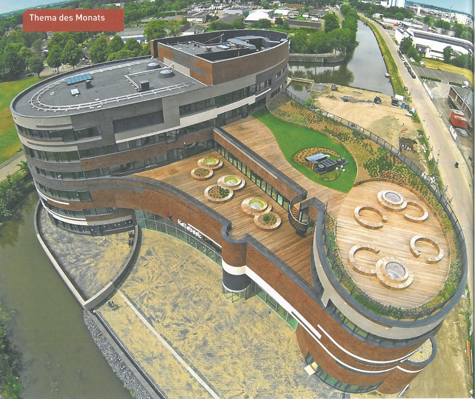
▲ Das Klimadach des Kellebeek College kombiniert die Vorteile eines Gründachs mit der Zwischenspeicherung von großen Regenwassermengen
