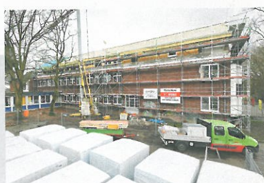
SANIERUNG Oben angebaut
