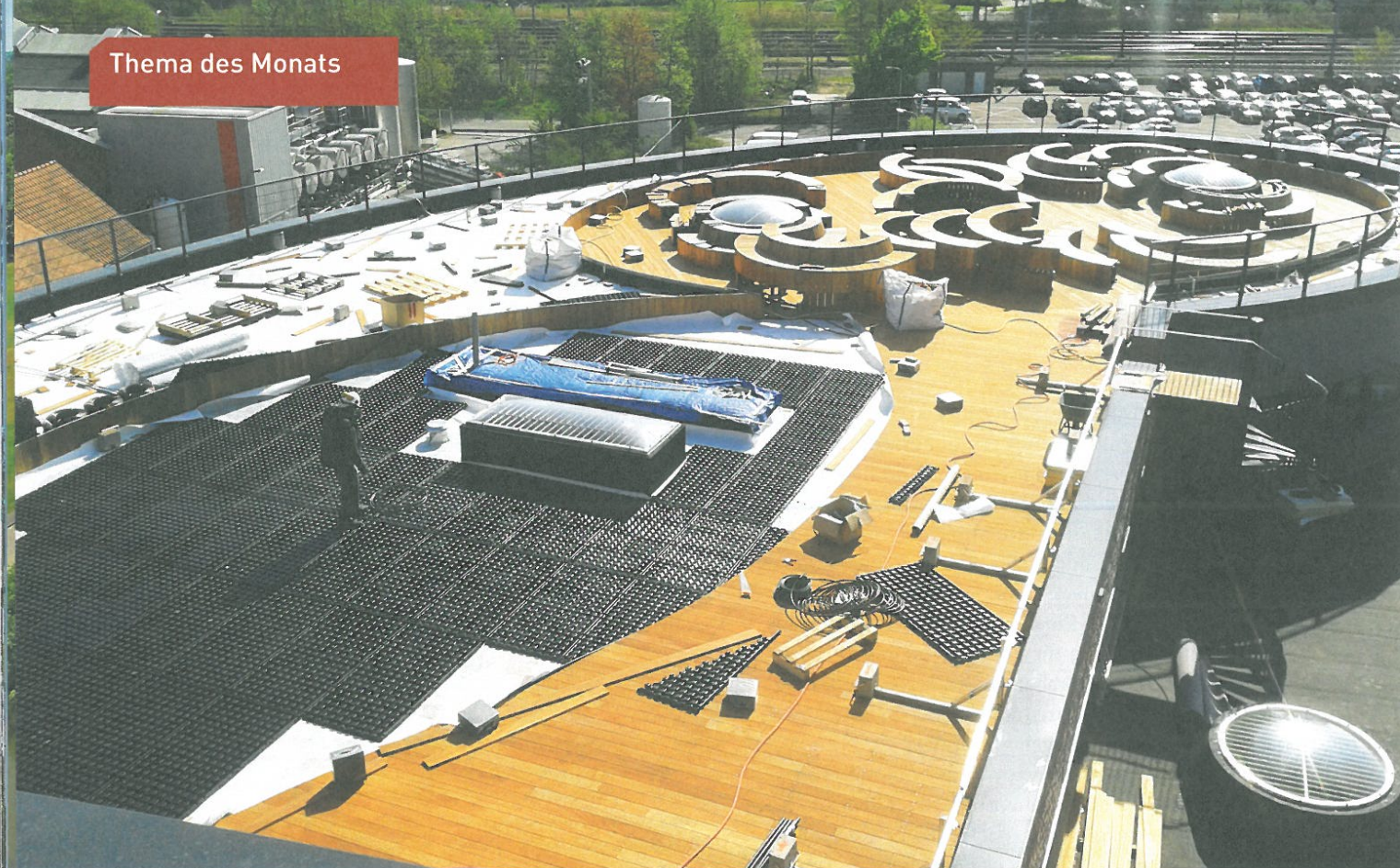
▲ Nachhaltige Dachlandschaft im Bau: Insgesamt wurden 750 m 2 der Flachdachflächen des Kellebeek College als Klimadach ausgeführt
