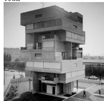
1.2 Logement EDF, Ivry-sur-Seine
